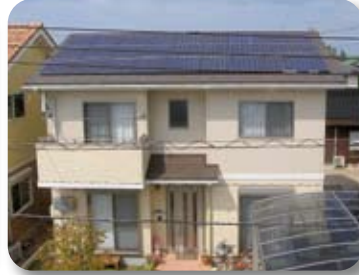
米子市 N.M 様邸 4.45kWシステム
