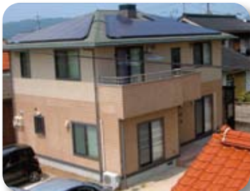
堺港市 K.H 様邸 3.57kWシステム
