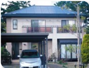
堺港市 T.N 様邸 3.69kWシステム
